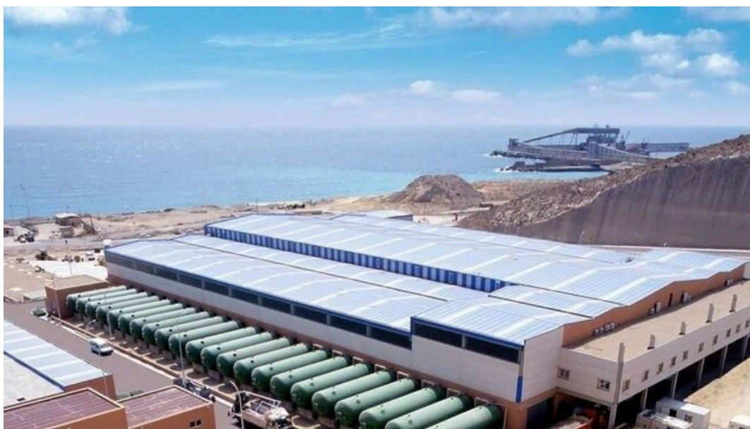
Una avería en la desaladora de Carboneras limita el suministro de agua en el Campo de Níjar
