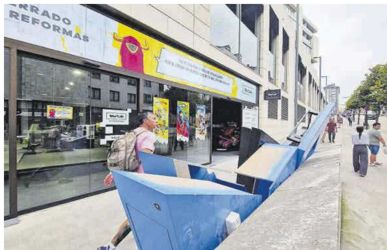
Varios peatones pasan junto al centro de ocio del Vasco, en obras con motivo de su reforma. | LNE
