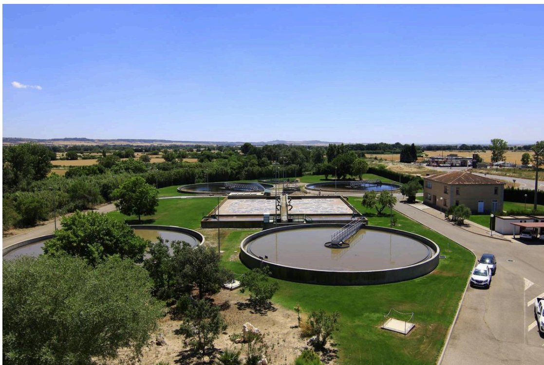
Aqualia gestiona la estación depuradora de aguas residuales de Huesca donde ha realizado inversiones en los últimos años. / Aqualia
